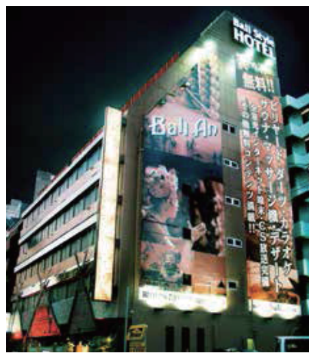
倉庫をレジャーホテルへ転用
